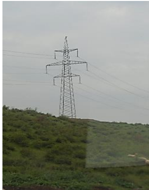
Şəkil 2-7: 330 kV-luq ikidövrəli aralıq dayağın trasda mümkün ümumi görünüşü
