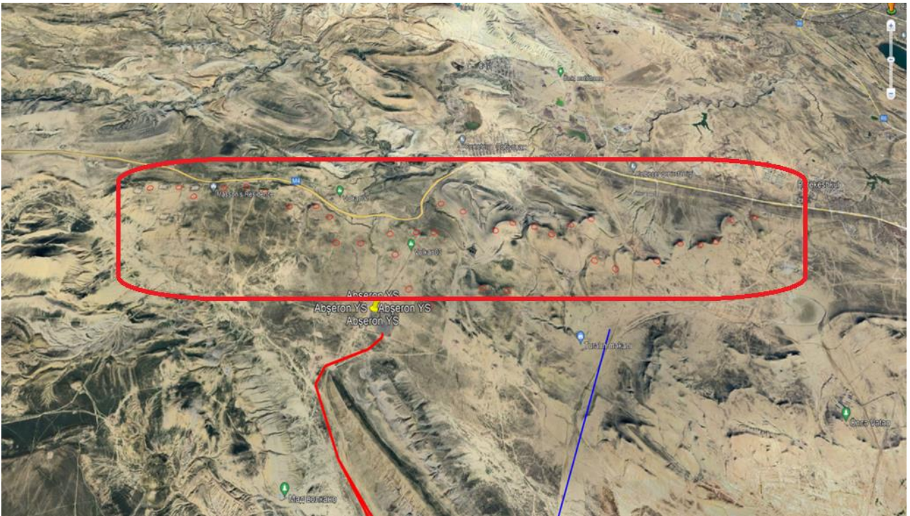
Şəkil 2-10: Abşeron KES-in yerləşdiyi yer
